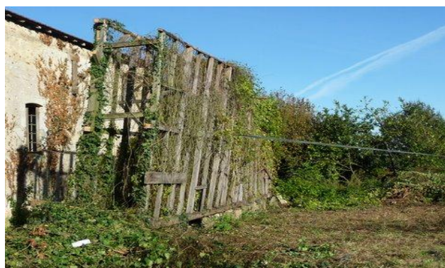
Enlèvement du crib
